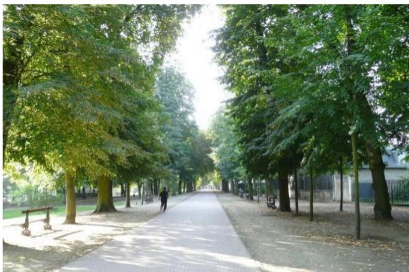
Stabilisé renforcé au centre, terre pierre en accotement pour accueillir stands ou véhicules, cette allée éclairée et posée sur remblai se trouve en position de léger belvédère sur le parc
