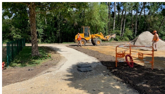
Empierrement des cheminements
