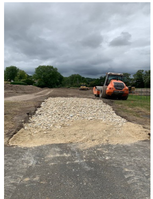
Terrassement et empièchement de la grande allée
